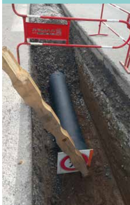
Pose de la conduite de diamètre 400 mm sous la RD525
