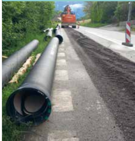
Le chantier a été mené par banalisation de la moitié de voirie de la RD525
