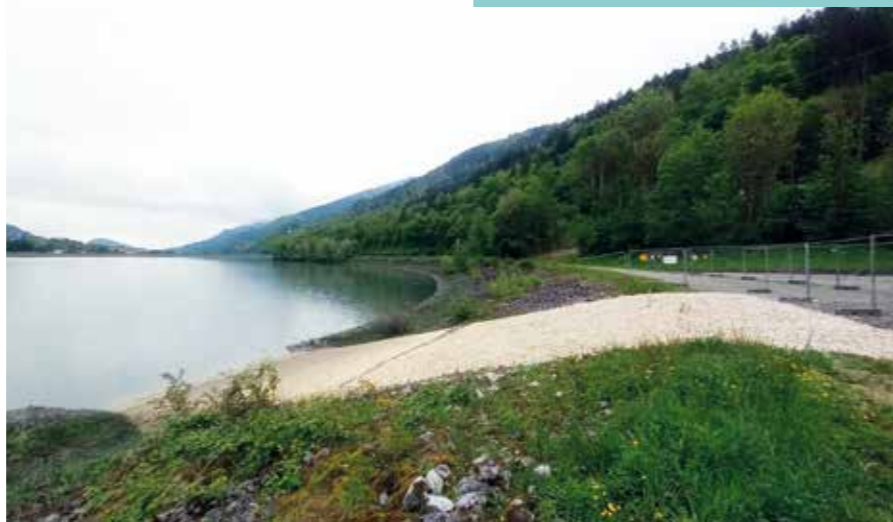
Aménagement de l'accès à la retenue du Flumet pour l'engin de dragage
