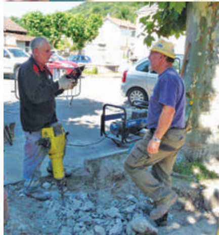
Travaux réalisés par les services techniques
