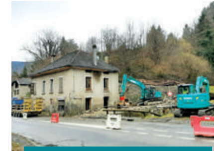
Démolition maison Champs du Pont
