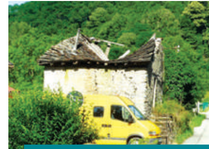
Démolition Grange Valloires
